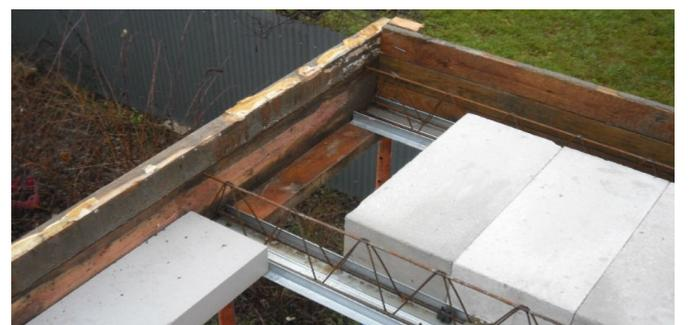
**Рис. 29 Деревянные щиты в качестве опалубки периметра перекрытия**
