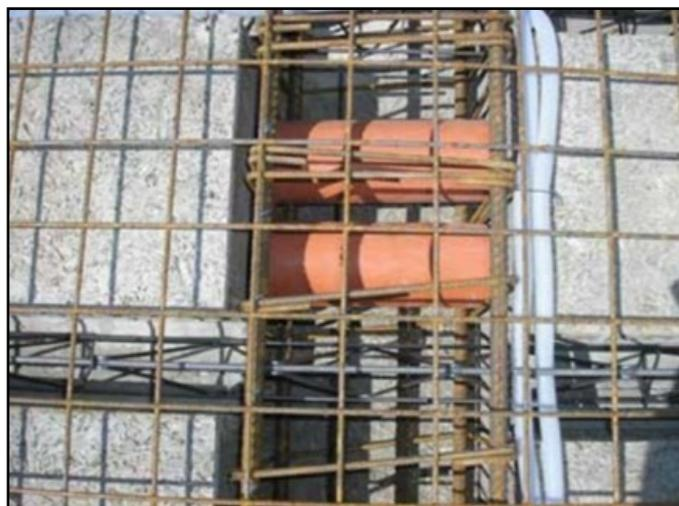
Рис. 22 Арматурная сетка в составе несъемной опалубки перекрытия
