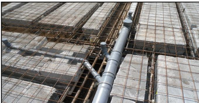
Рис.30 Прокладка канализации в опалубке перекрытия
