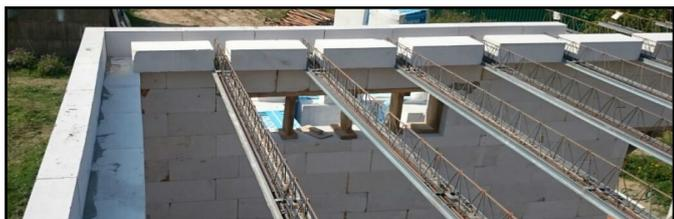
Рис. 1 Фиксация расстояния между балками с помощью блоков
