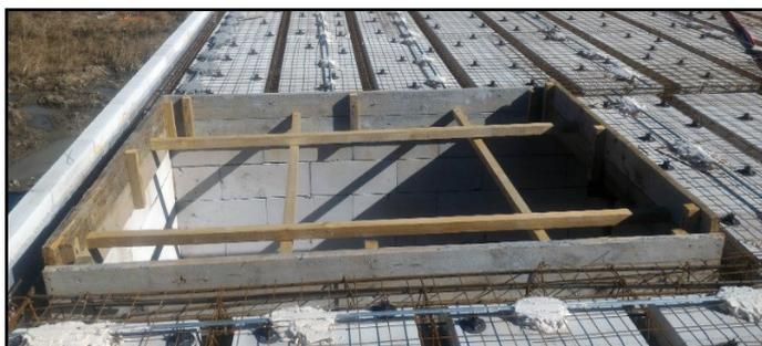
Рис. 18 Деревянная опалубка лестничного проема
