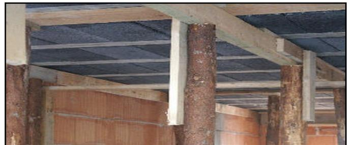
**Рис. 10 Пример фиксирующей системы из древесины**
