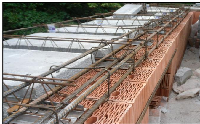
Рис. 13 Арматурный каркас монолитного пояса на стенах из теплой керамики
