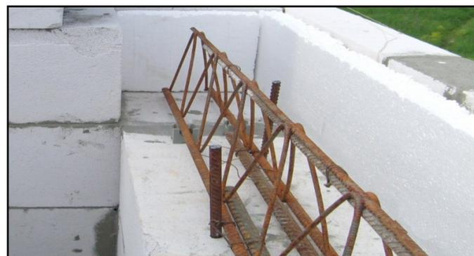
Рис. 16 Треугольный арматурный каркас в составе монолитного пояса перекрытия
