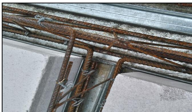
Рис. 4 Пример армирования стыковочного узла
