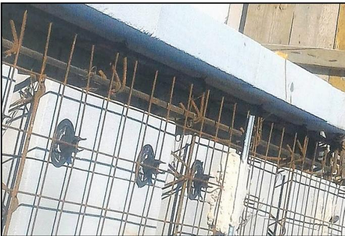
**Рис. 24 Пересечение арматурной сетки с каркасом монолитного пояса**
