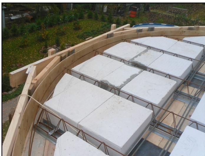
Рис. 19 Опалубка круглого балкона из фанеры в опалубке перекрытия
