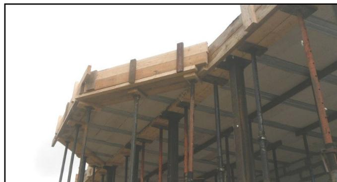
Рис. 20 Устройство балкона в перекрытии
