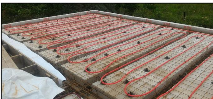
Рис. 31 Прокладка водяного теплого пола в несъемной опалубке перекрытия МАРКО
