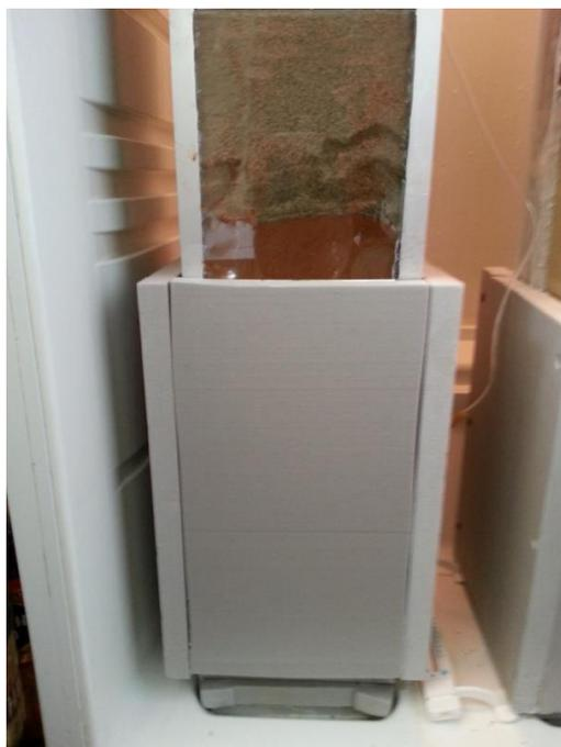
*Рисунок 2. Теплоизоляция плитами из экструзионного пенополистирола
