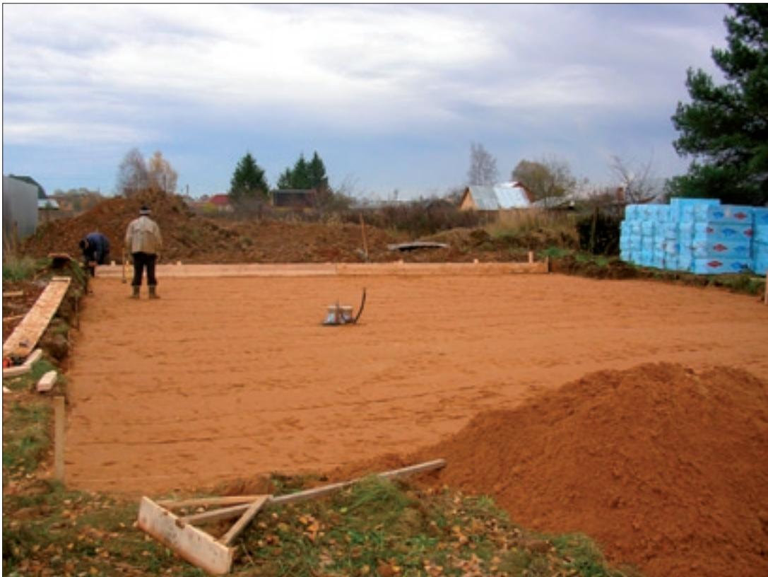
Рисунок 7.2 Уплотнение грунта до укладки теплоизоляции STYROFOAM GEO
