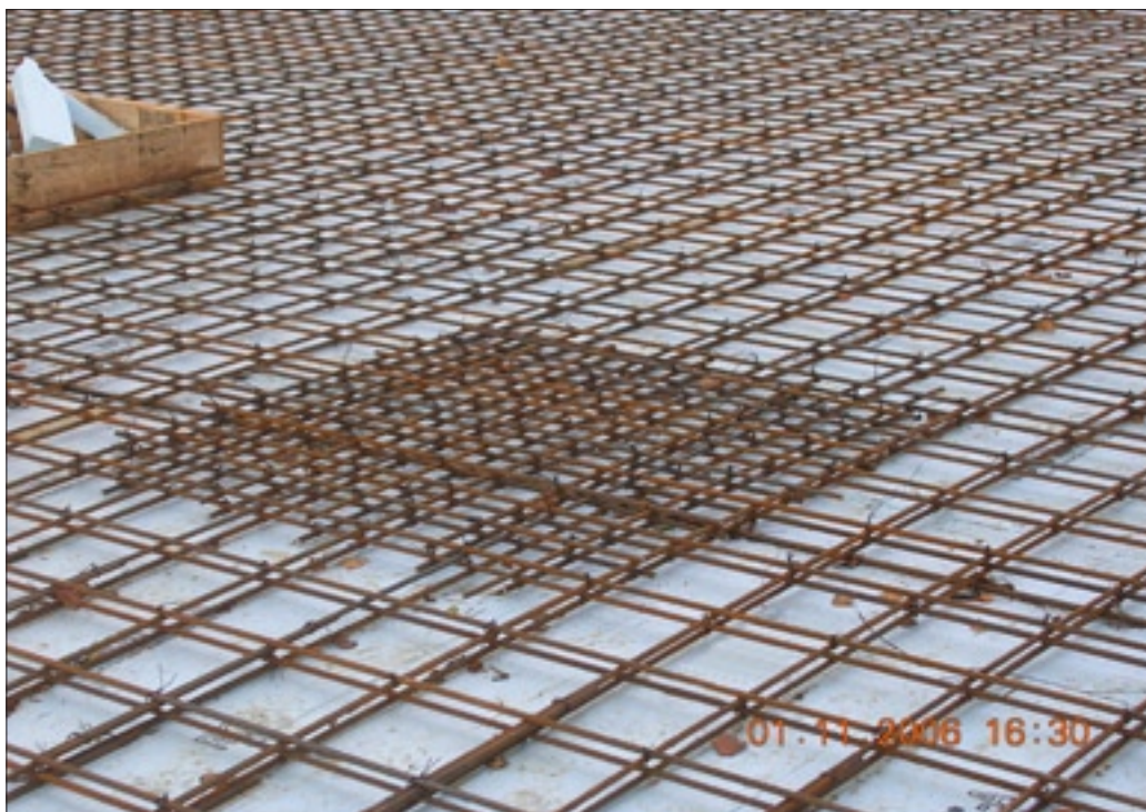
Рисунок 7.5 Схема раскладки арматуры по теплоизоляции STYROFOAM GEO
