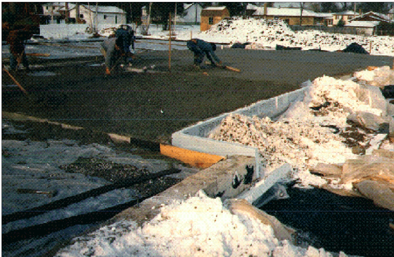
Рисунок 7.8 Укладка бетонной смеси
