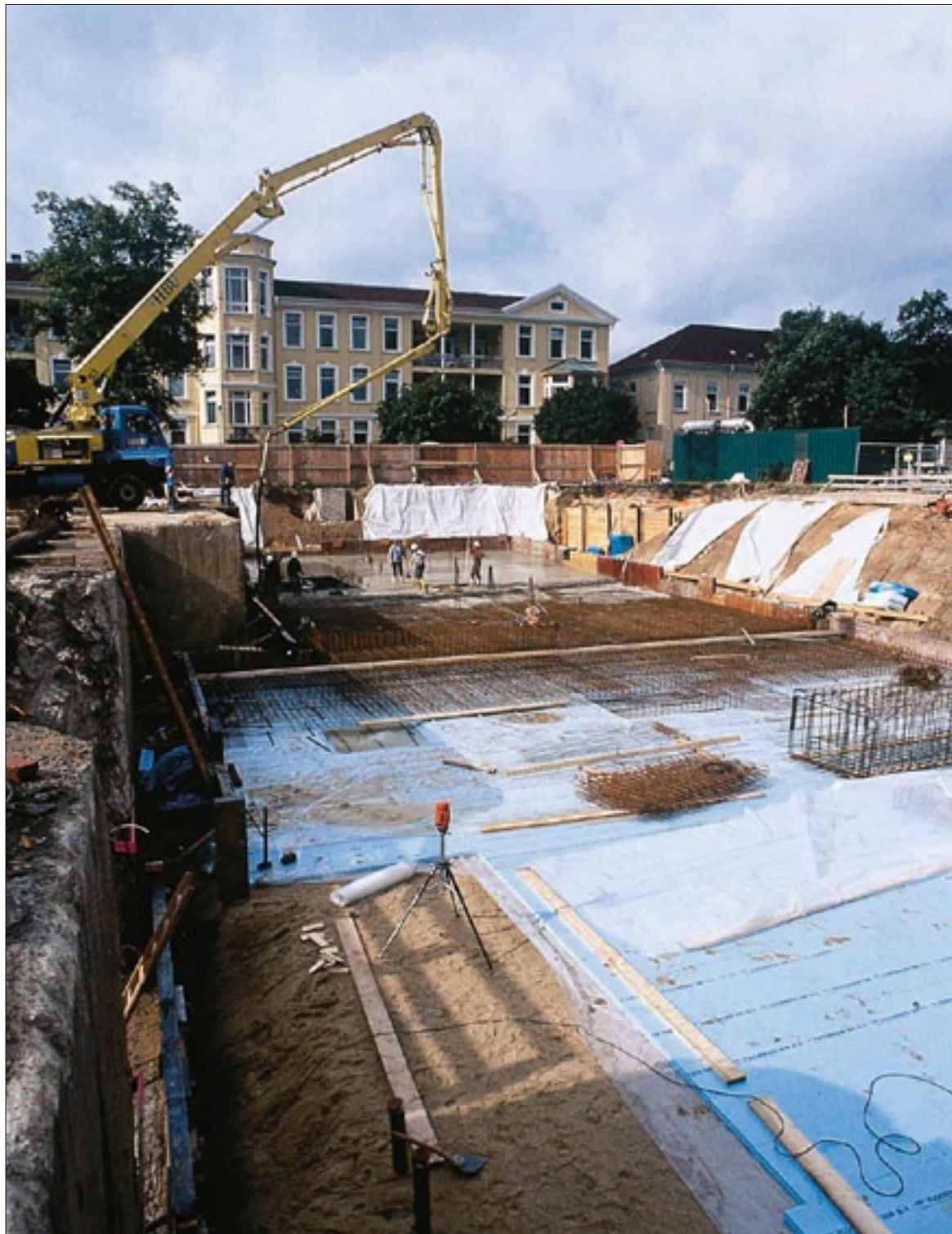
Рисунок 7.1 Производство работ по теплоизоляции STYROFOAM GEO
